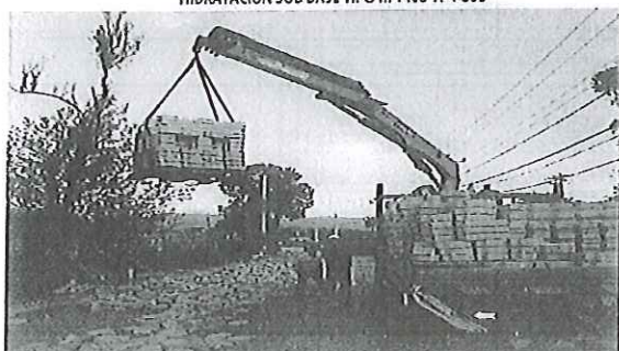
HIDRATACIÓN SUB BASE TIPO III +400 A + 800
